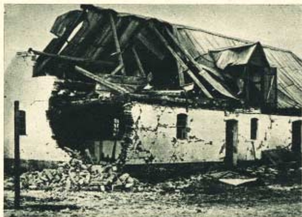
I Erstatninger for Bombeskader har Krigsforsikringen for Bygninger siden Krigsudbruddet udbetalt adskillige Mill. Kr.
