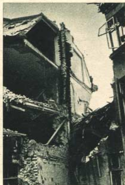
En Ejendom i Gunløsgade i København efter Eksplosionen af en 225 kg Sprængbombe, der havde ramt Ejendommen under Angrebet den 27. Januar 1943. Læg Mærke til, at alle Etagerne er raseret. Kælderen var derimod ganske uskadt
