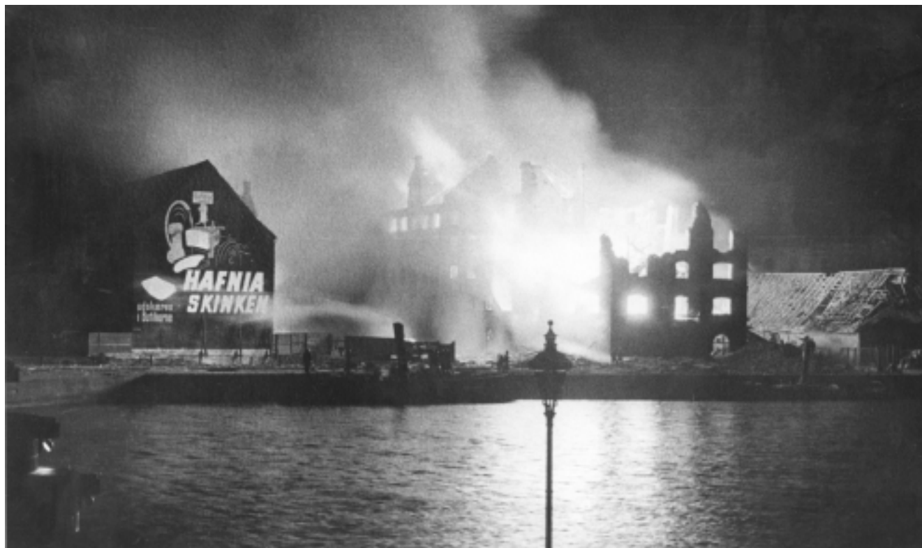
Ved angrebet på B&W's dieselmotorfabrik på Christianshavn den 27. januar 1943 blev to fabrikker, som lå ved siden af B&W, en sukkerfabrik og en lommestøklædefabrik, også ramt. Her er det lommestøklædefabrikken, der brænder.
